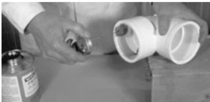
**10.** Enseguida, agresivamente aplique el Primer en la parte final de la tubería a un punto de 1/2" (15 mm) más allá de la profundidad del casquillo de la conexión.
