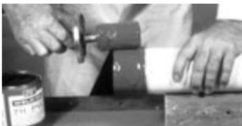
**16.** Sin demora, mientras el cemento está todavía húmedo, ensamble la tubería y la conexión. Use suficiente fuerza para asegurar que la tubería sienta en el casquillo de la conexión. Si el posible, dele un 1/4 de vuelta a la tubería al tiempo que la inserta.
