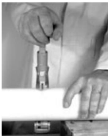
**4.** Remueva todo el reborde y todos las rebabas de ambos lados, interior y exterior, de la tubería con un cuchillo, lima o escariador. Las rebabas pueden raspar canales en las superficies pre-ablandadas ó crear topes dentro de las paredes de la superficie.
