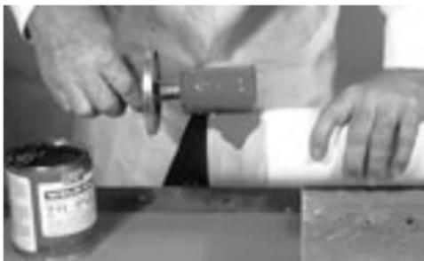
**14.** Agresivamente aplique una capa mediana de cemento en el casquillo de la conexión; evite anegar de cemento en el casquillo. En tubo de campana, no permita que el cemento corra más allá de la campana.
