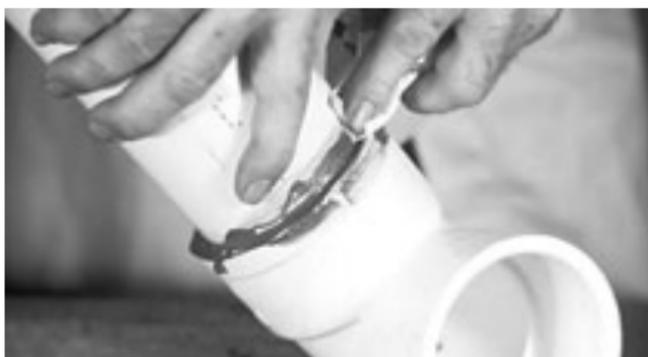
**19.** Usando un trapo, remueva el exceso de cemento de la unión incluyendo el anillo ó moldura, porque esto ablandaría inutilmente la tubería y el accesorio y no agregaría resistencia a la unión. Evite mover la unión.
