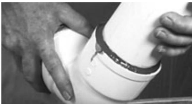
**18.** Después de ensamblar, la unión debe tener un anillo ó moldura de cemento completamente alrededor. Si hay espacios presentes en este anillo, no fué aplicado suficiente cemento y la unión puede ser defectuosa.
