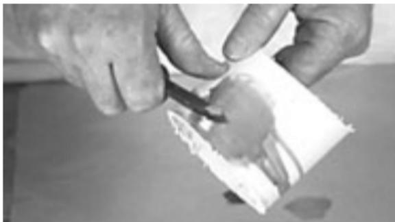
**9.** Usando el aplicador correcto (como se delineó en el paso #7) agresivamente aplique el Primer dentro del casquillo de la conexión, manteniendo la superficie y aplicador mojados hasta que la superficie ha sido suavizada. Más aplicaciones pueden ser necesarias para superficies duras y condiciones de clima frío. Re-sumerga el aplicador en el Primer como se requiera. Cuando la superficie tenga el Primer, remueva cualquier anegación de Primer del casquillo de la conexión.
